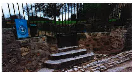
Parquet, poncé et décapé et escalier, poncé et décapé
