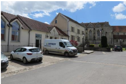
Poche de stationnement du pôle équipements (rue de l'Église)
