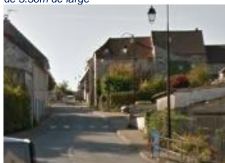
Grande rue, barreau Sud (en entrée de l'hyper-bourg) - Trottoirs inférieur à 1.50m et chaussée de l'ordre de 6.00 de large
