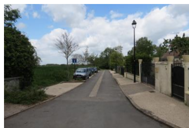
Stationnement en linéaire au niveau de la rue des Ménétriers
