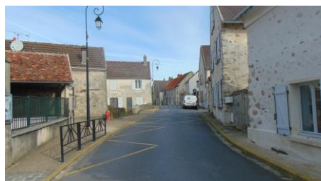
Grande rue, barreau Nord au niveau de l'école trottoirs inférieur à 1.00 m, chaussée de l'ordre de 5.50m de large
