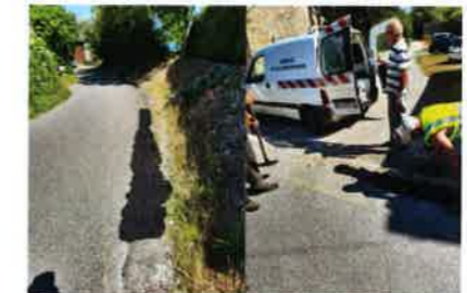
Réfection de la chaussée
