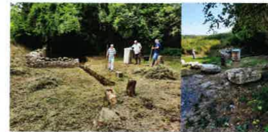
Nettoyage et protection du lavoir de la route de Crouy
