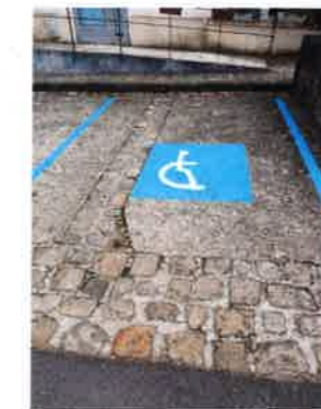
Création d'une place PMR devant la salle des fêtes
