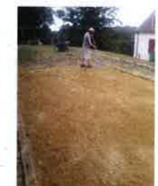
Remise en état du terrain de pétanque vert
